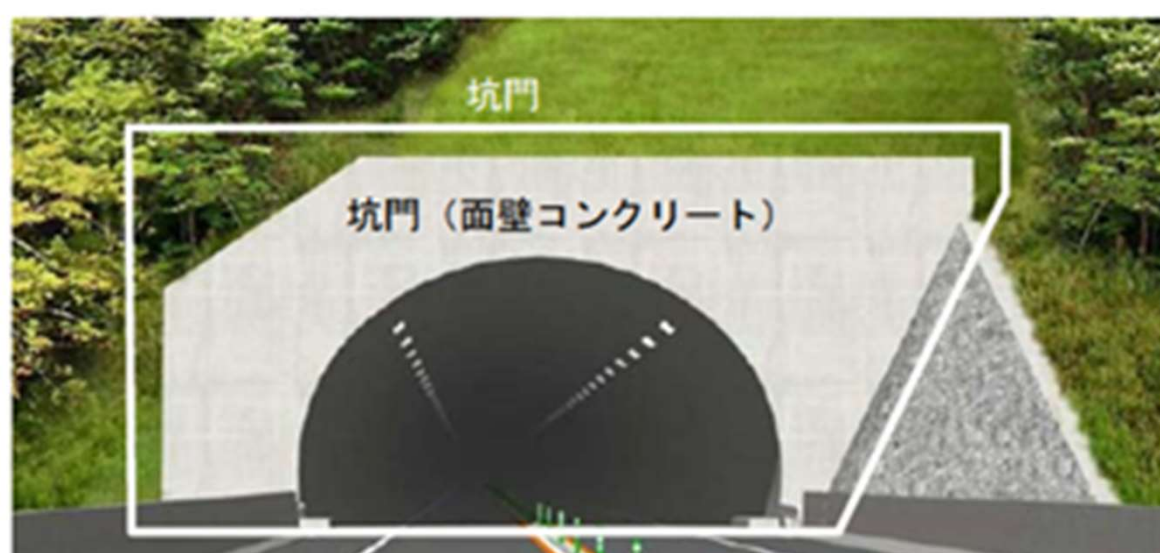
別図-1.2 点検対象箇所（トンネル坑口部）
