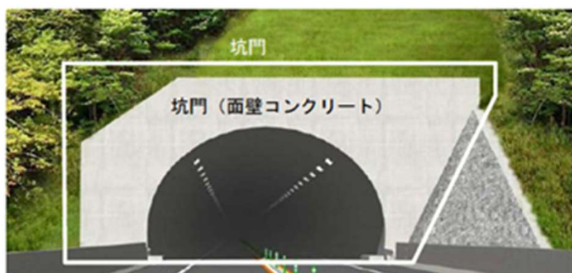
別図-1.2 点検対象箇所（トンネル坑口部）
