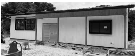
建設中の「猟師工房 松風」
