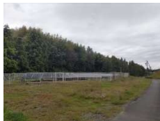
写真⑤：東側から
