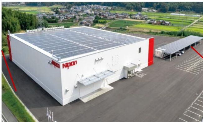
図4-9. 再エネ自家消費実証工場 ニプロン 三重スマート夢工場
