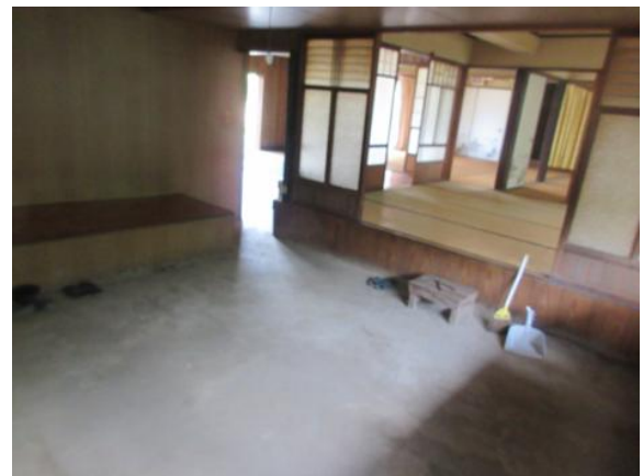
キッチン部土間
