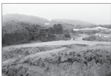
土取り造成中のクリスタル工業団地
