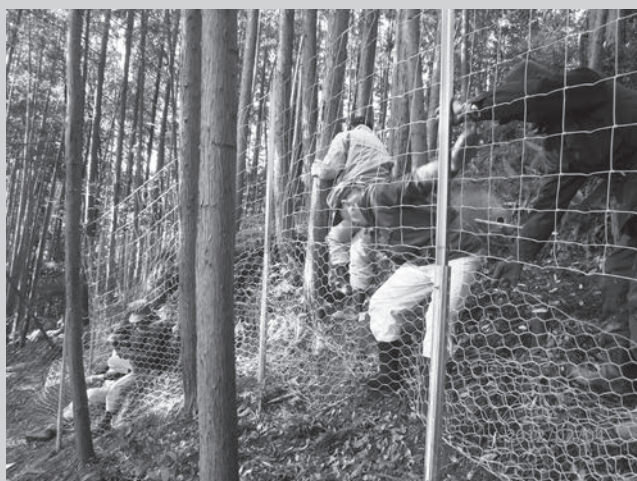
獣害防除柵設置作業
