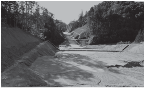
広域農道工事(神坂付近)長谷方向を望む
