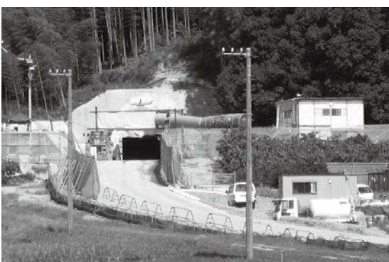
松阪第1トンネル
