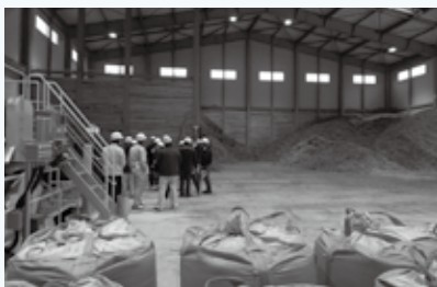
木材チップ集積投入機械現場
