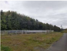
写真⑤：東側から
