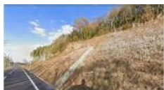
写真③：南西側から
