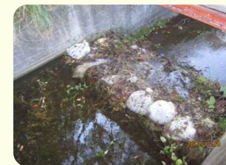
土のうによる洪水吐のかさ上げ
